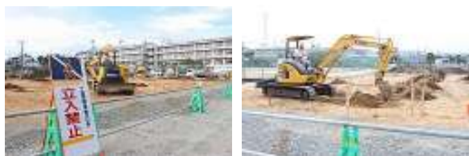
▲原町第二中学校前の市有地▲重機を使っでの作業
